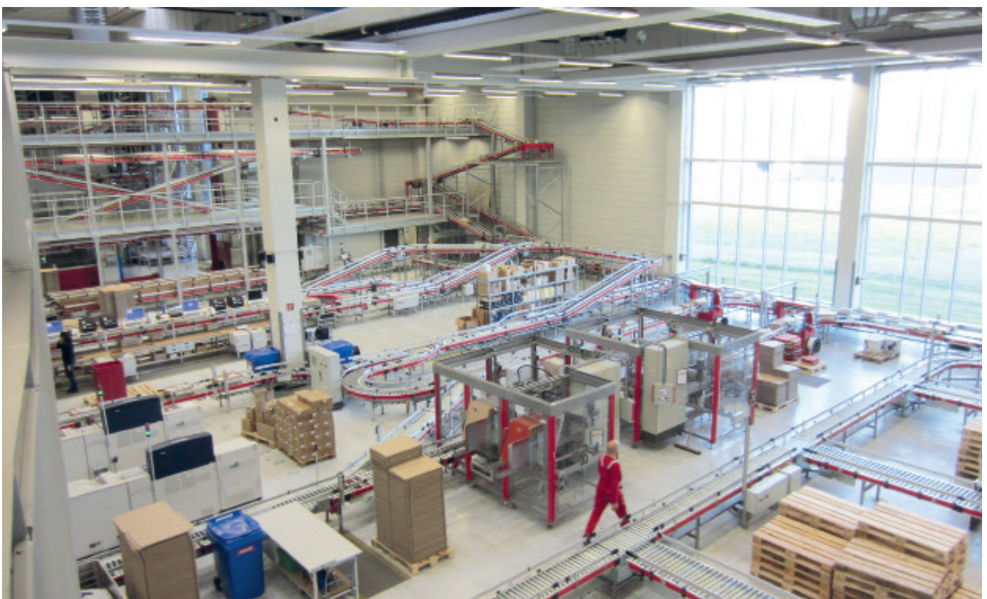
Verpackungs- und Versandbereich eines Distributionscenters
