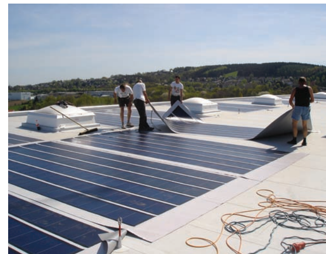
Dank des niedrigen Gewichts (ca. 4 kg/m 2 ) lassen sich die Bahnen leicht verlegen.
