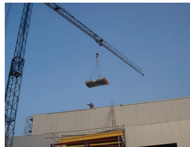
Die Solar-Dachbahnen wurden mithilfe eines Krans auf das Dach befördert.
