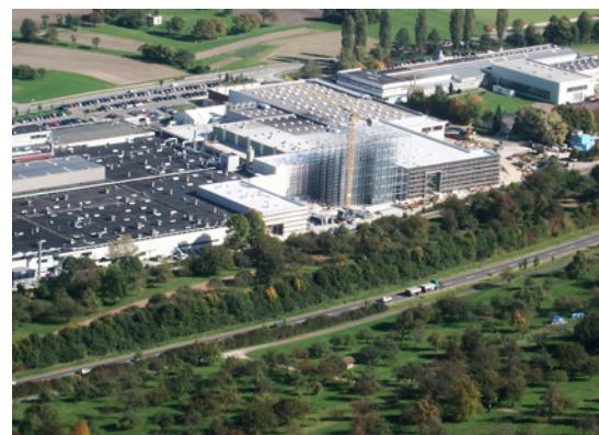
Das neue Lager ist 70 m lang, 27 m breit und 28 m hoch. Es verfügt über ein vollautomatisches Hochregallager sowie ein Schwerlast-Tablarlager.
