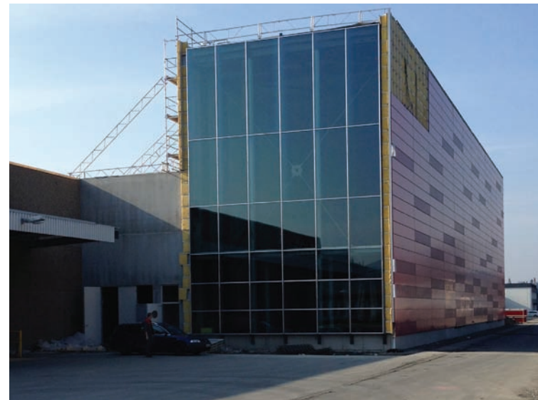
Das AKL in seiner letzten Bauphase
