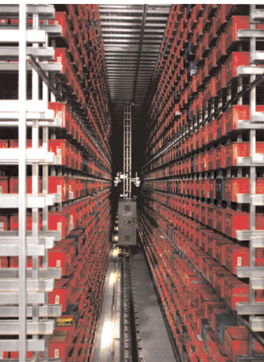
Blick in die Gasse des Stahlbehälter-AKL mit dem Regalbediengerät „Mustang“ von TGW.
