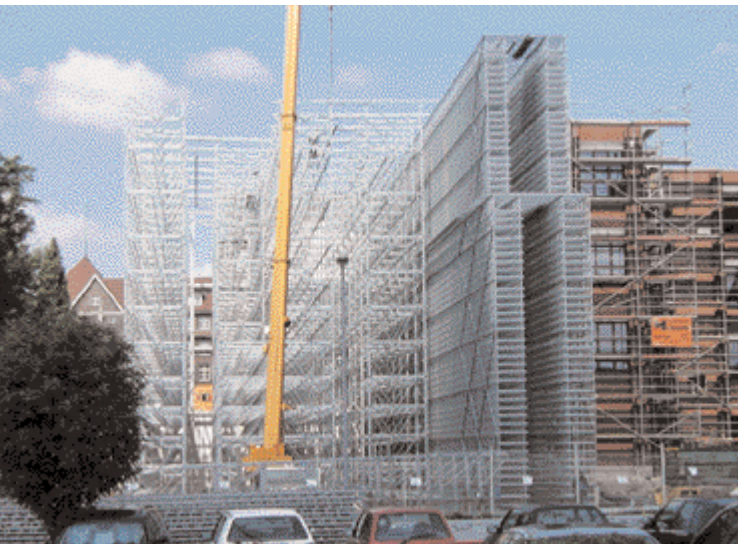
Der Rohbau für die 62 m lange, 19 m breite und 21 m hohe Halle .
